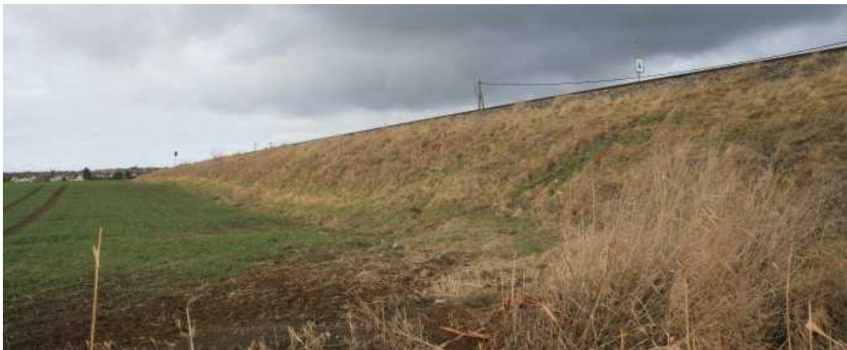
Abb. 7: Bahndamm der Bahnstrecke Naumburg (Saale) – Artern entlang der nördlichen Grenze des Vorhabengebietes.
