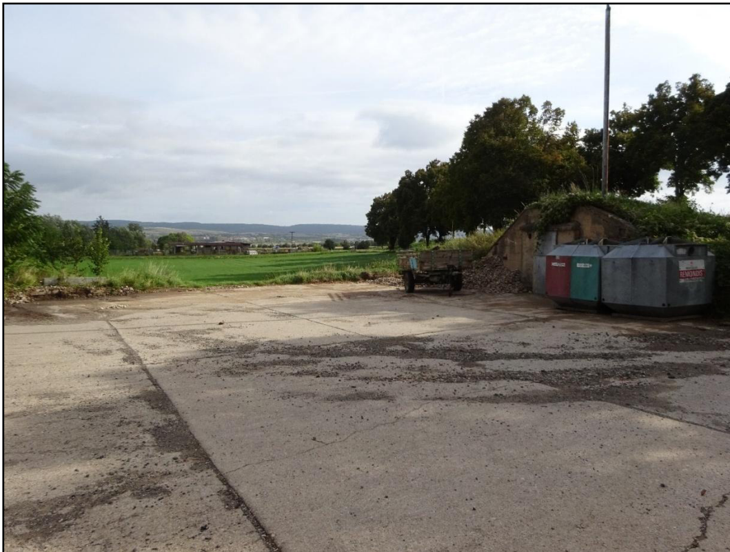
Abbildung 9 Blick auf die versiegelte Fläche im Süden – zukünftiger Parkplatz (Aufnahme: 17.09.2025)
