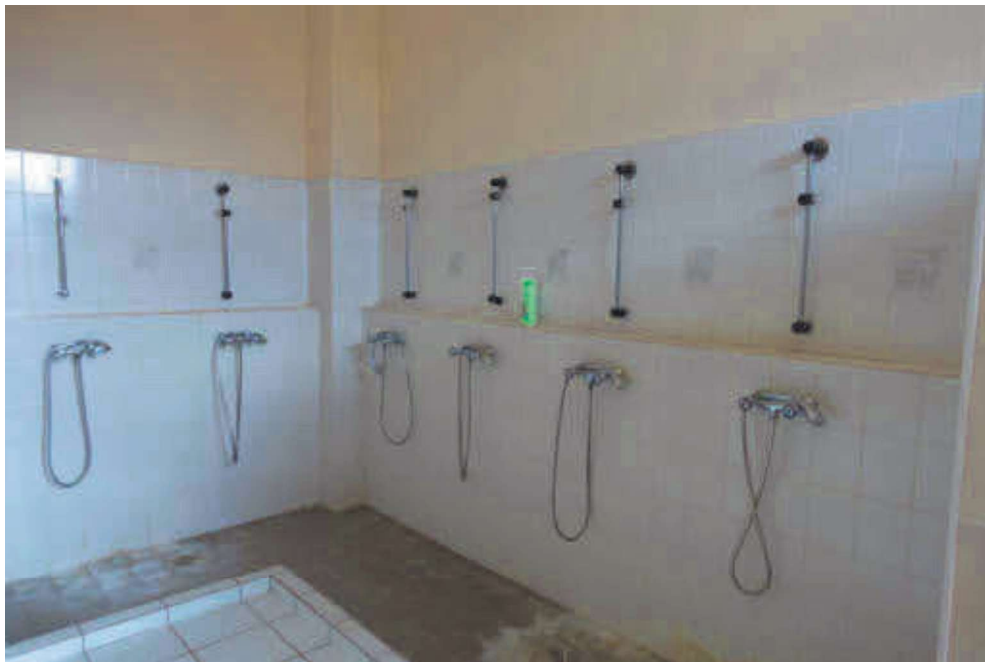
Sanitär Gebäude III
