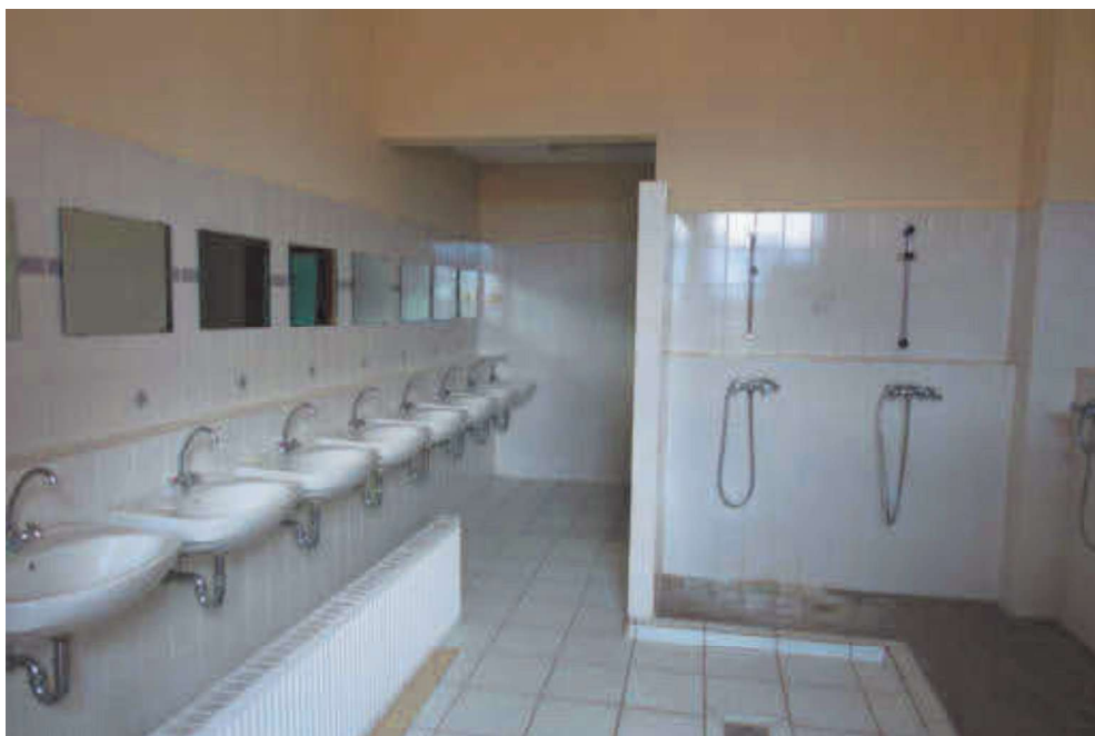
Sanitär Gebäude III
