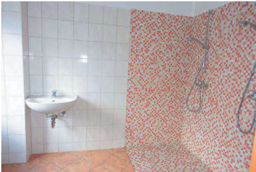
Sanitär Gebäude II
