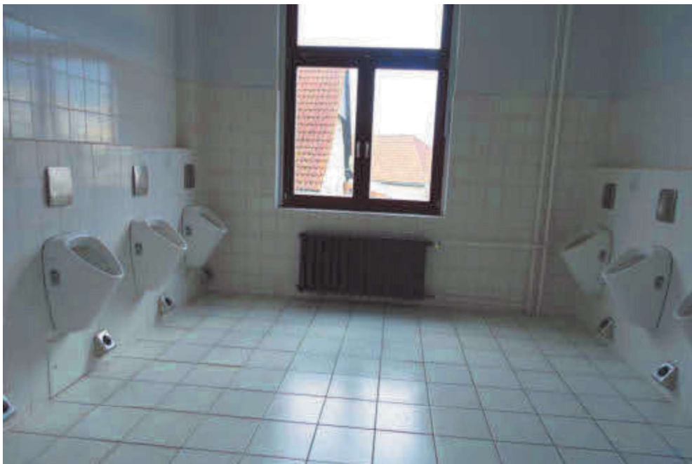
Sanitär Gebäude III
